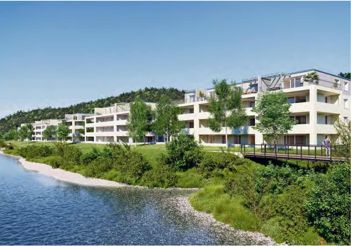
Die Wohnüberbauung Verdeblu in Kollbrunn wird ganz in der Nähe der Töss gebaut, die dafür teilweise revitalisiert wird.
